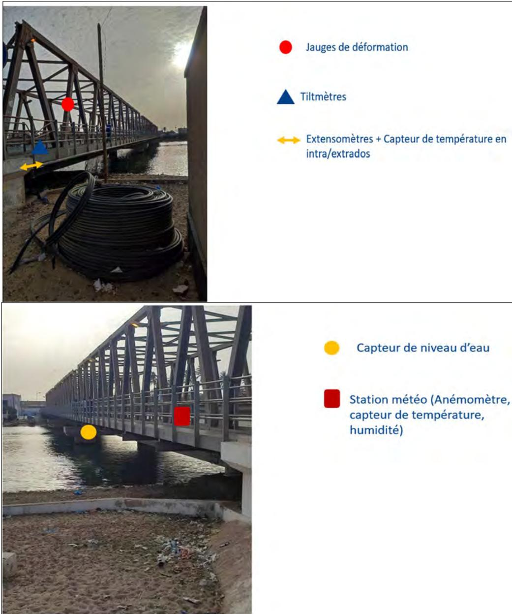
Figure 54 : Capteurs à mettre en place sur le pont Massack Ndiaye
