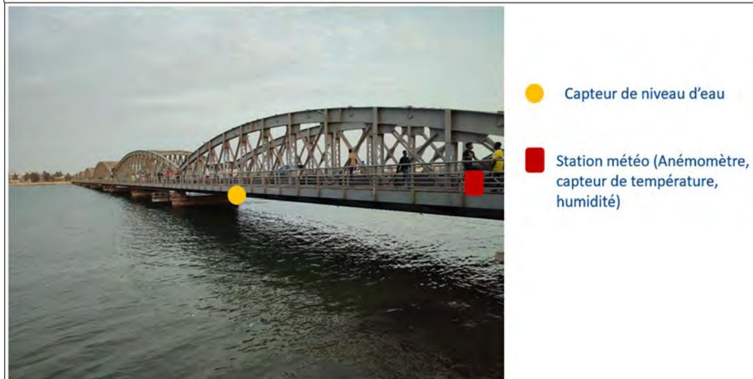
Figure 55 : Capteurs à mettre en place sur le pont Faidherbe
